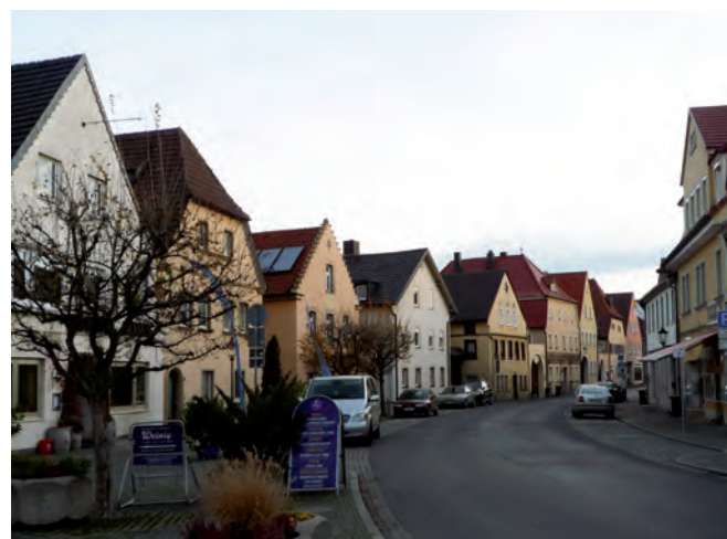
Ackerbürgerhäuser Rügshöfer Straße
