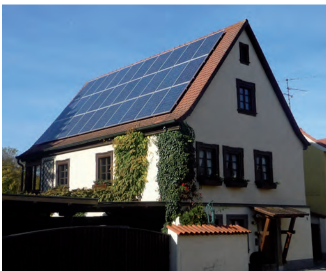
Beispiele für Photovoltaikanlagen in Gerolzhofen
